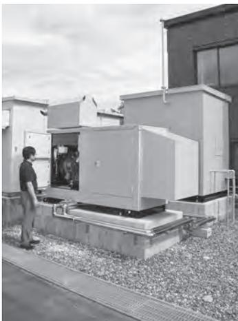
昨年12月に新設された清水町役場の非常用発電機。出力80キロワットで、庁舎で通常必要とする電力の7割弱を、最低72時間供給できる
